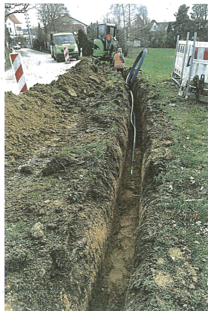
Graben ausheben, Leerrohre rein, Glasfasern einblasen – in Langenpettenbach wird gerade am Glasfasernetz gebaut. KN
