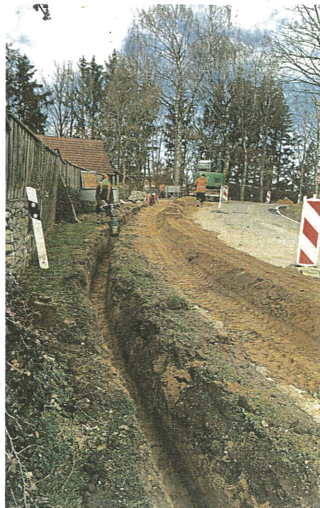
Graben ausheben, Leerrohre rein, Glasfasern einblasen – in Langenpettenbach wird gerade am Glasfasernetz gebaut. KN
